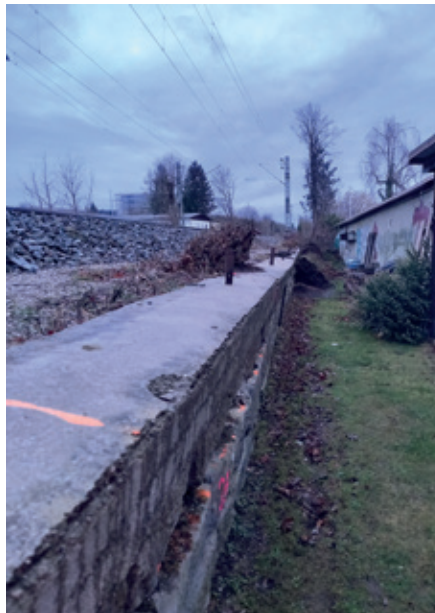
Sanierungsfall Stützwand mit starker Schiefstellung
