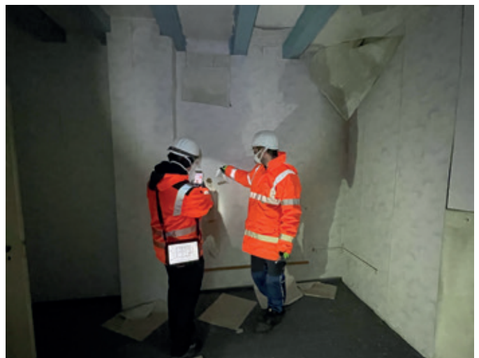
Probennahme und Schadstofffassung im Gebäude
