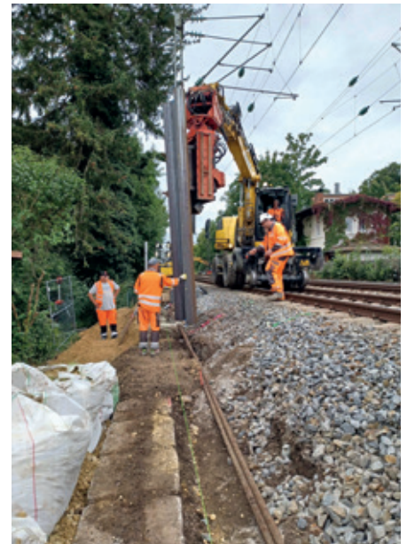
Einbringen der Spundwand
