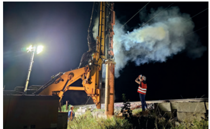
Erkundungsarbeiten (hier: DPH) Begleitung der Rammarbeiten an einer Schlagramme im Nachtbetrieb
