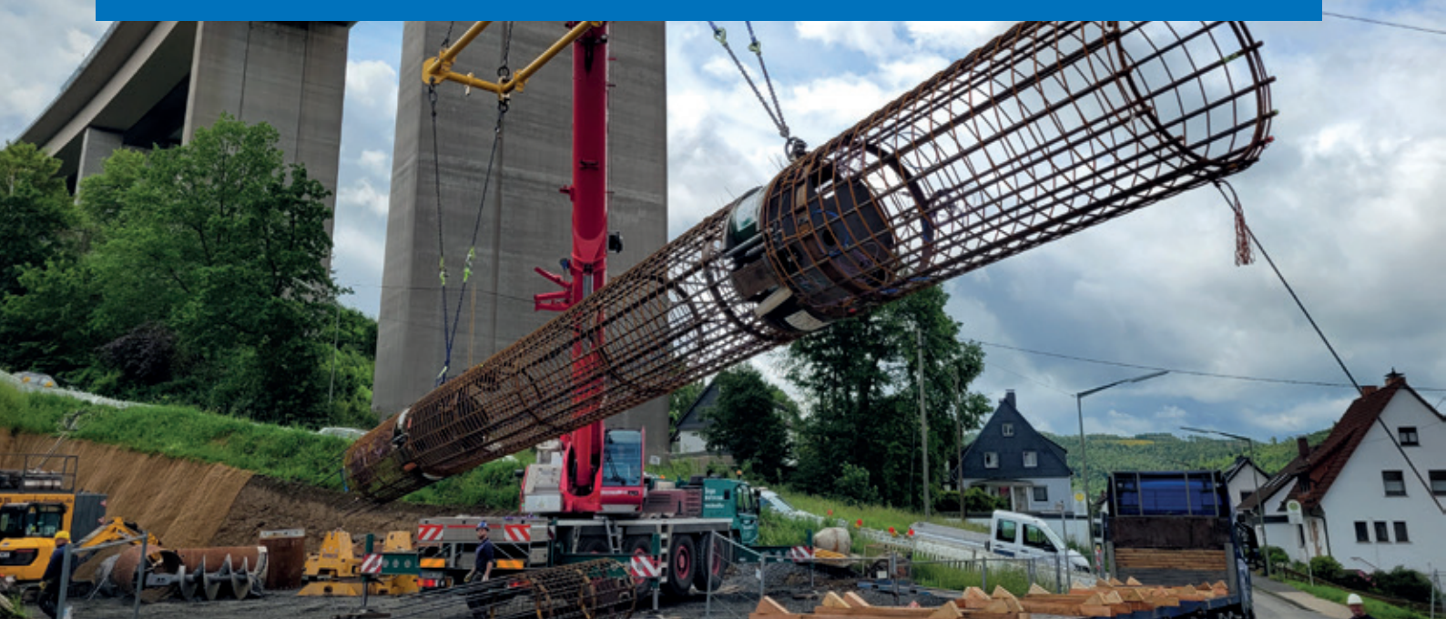
Bewehrungskorb mit Pressenebene unter der Siegtalbrücke
