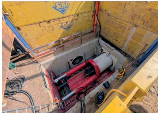
Startgrube des Rohrvortriebs DN 1400
