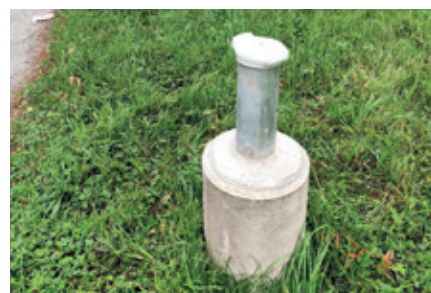
Fertiggestellte GWM an der Gleiwitzer Straße
