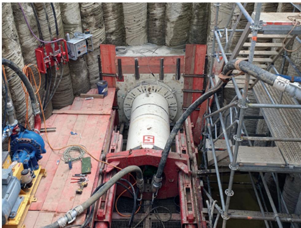
Blick in eine Vortriebsbaugrube mit Bohrfpahlwand
