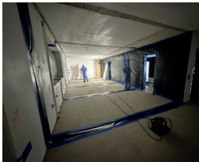
Sanierung asbesthaltiger Wand- Decken- und Bodenbeläge
