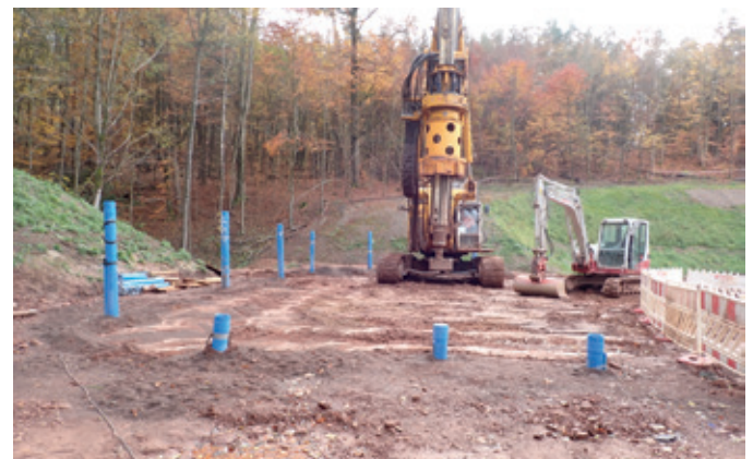
Großbohrgerät innerhalb Bohrpfahlumschließung mit Drainagesäulen
