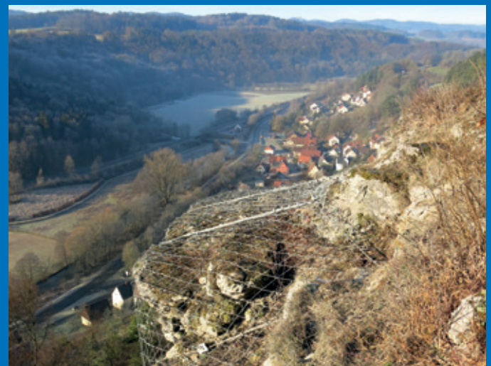
Labiles Gesteinsmaterial durch Übernetzung gehalten
