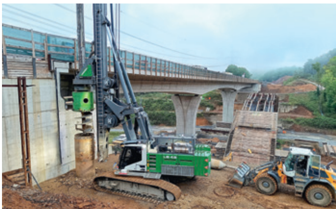
Bohrpfahlherstellung für Talbrücke Bechlingen
