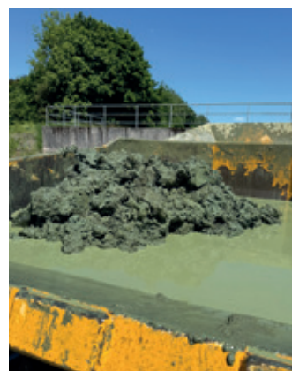
Durch den Bohrvorgang gestörtes Aushubmaterial
