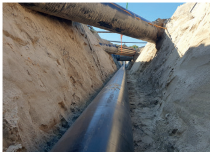
Rohrgraben mit Leitungsquerungen
