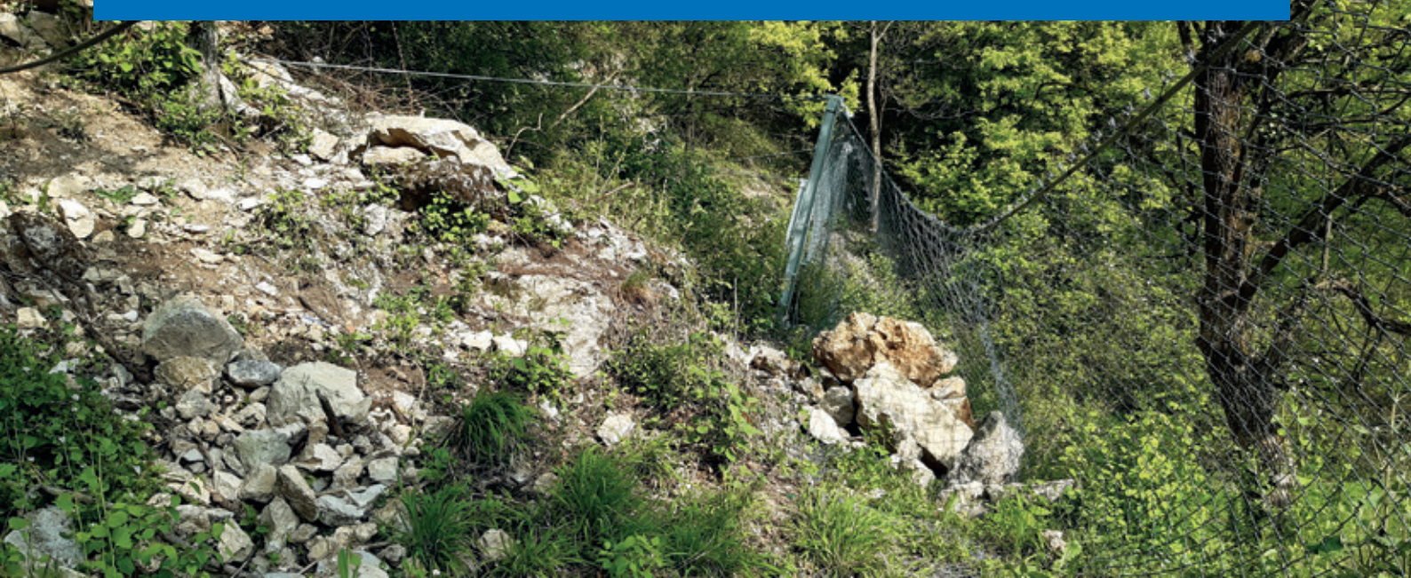
Blockschlag im Fangzaun – Gelungene Felssicherung
