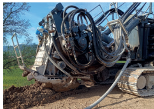
Ein FMI-Gerät bei der Verbesserung eines Bahndamms
