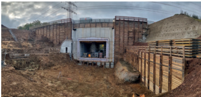
Baugrube für Flachgründung Unterführung Holzerbach unter A45
