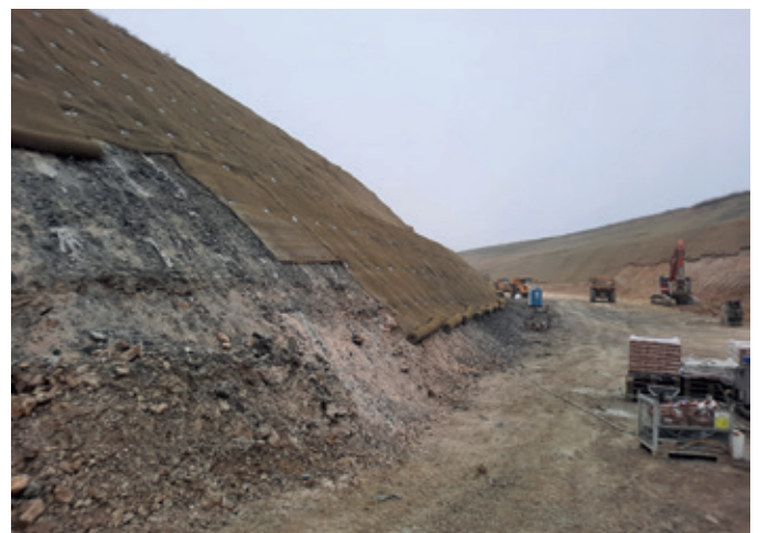
Sicherung durch Übernetzung mit Stahldrahtgeflecht
