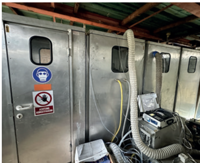
Technische Schutzmaßnahmen: Personalschleuse
