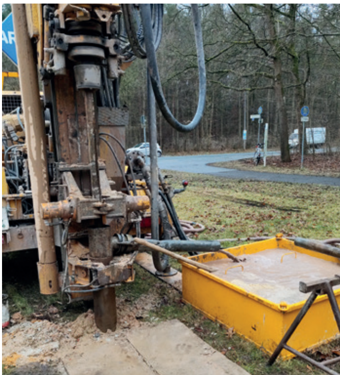
Abteufen der Kernbohrung für die GWM
