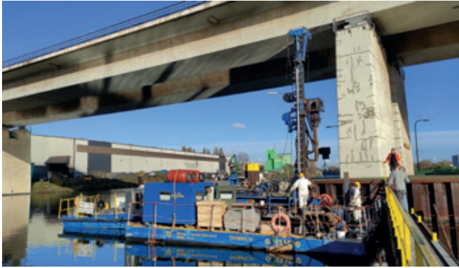
Pontonbohrung im Hafenbecken
