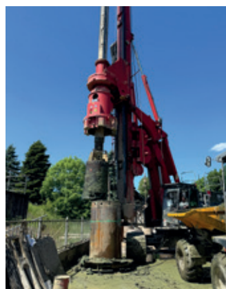
Bohrfortschritt im Übergangsbereich zum Grünsandmergel
