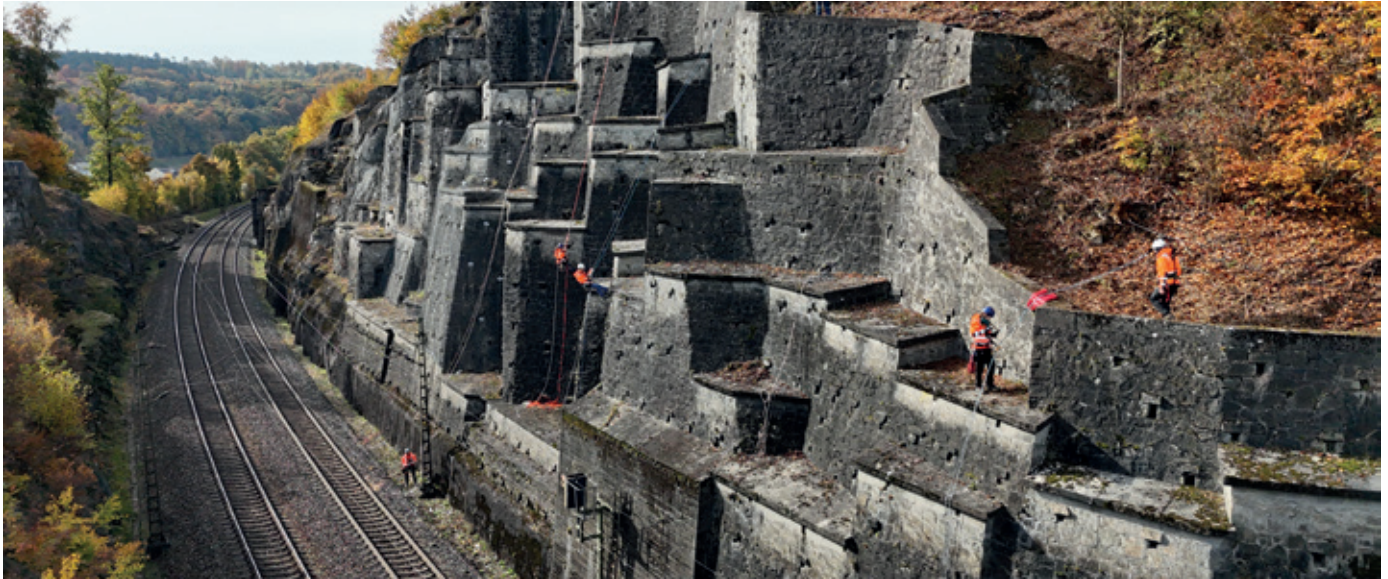
Bauwerkskontrollen durch Höhenarbeiter am Stützbauwerk südlich von Treuchtlingen
