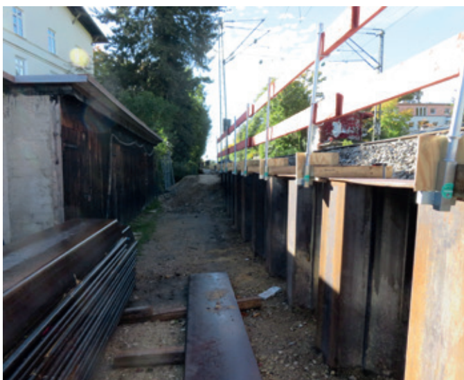
Spundwand mit sehr geringem Abstand zur Nachbarbebauung
