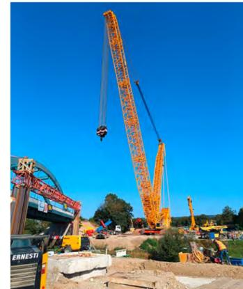
Rampenkrane für den Einbau der Stahlbogenbrücke
