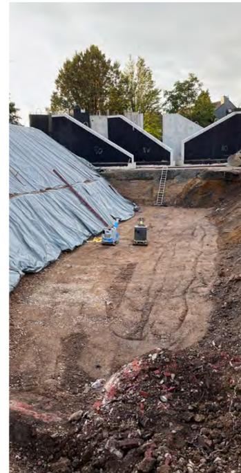
Baugrubenaushub auf Gründungsniveau für den Einbau des Bodenaustauschs (Brückenterteile im Hintergrund)
