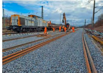
Abladen und Verlegen der Gleisschwellen
