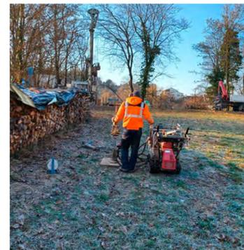
Landseitige Sondierung durch die Dr. Spang GmbH mit Kernbohrung auf der Dammkrone
