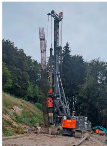
Einsetzen Bewehrungskorb in Bohrpfehl
