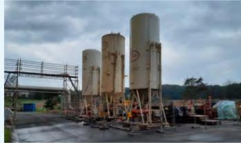
Baustelleneinrichtung mit Silos, gefüllt mit Dämmmaterial
