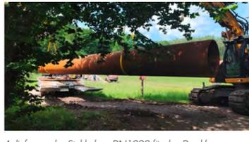
Anlieferung des Stahlrohres DN1000 für den Durchlass
