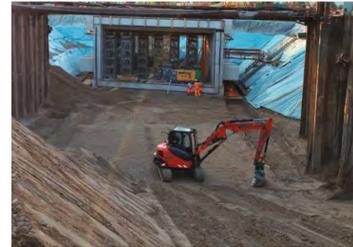
Herstellgrube mit Eisenbahnüberführung in Endlage
