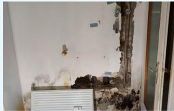
Großzügige Bauteilöffnung zur Probenahme an Leitungssträngen
