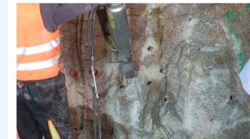
Lösen von kompaktem Granitgestein mittels Bohren und Spreizen
