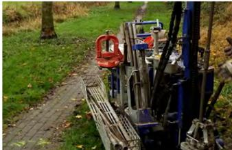
Kleinrammbohrungen und Schwere Rammsondierungen im Abschnitt A.2 in Finkenwerder
