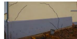
Setzungsrisse aufgrund mangelhafter Unterfangung
