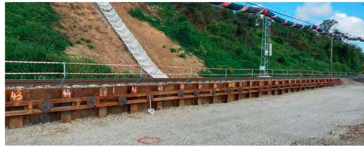
Gleislängsverbau für den eingleisigen Bahnbetrieb
