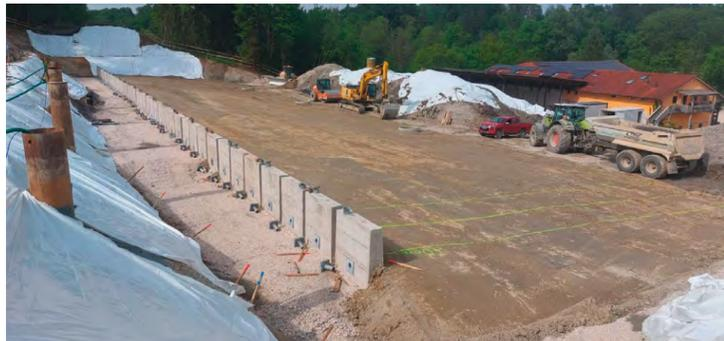
Einbau Winklelemente für Totmannkonstruktion
