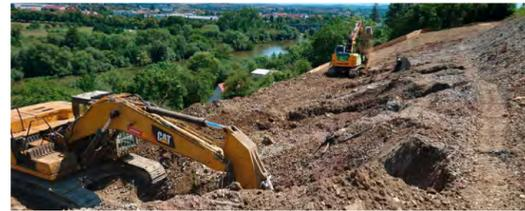
Einbau HZV Stützkörper unterhalb der DB-Strecke
