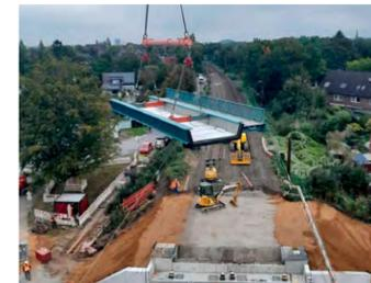
Einhub eines der zwei Stahlüberbauten
