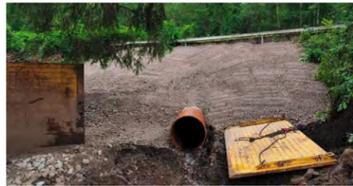
Eingebautes Stahlrohr und abgeflachter Damm
