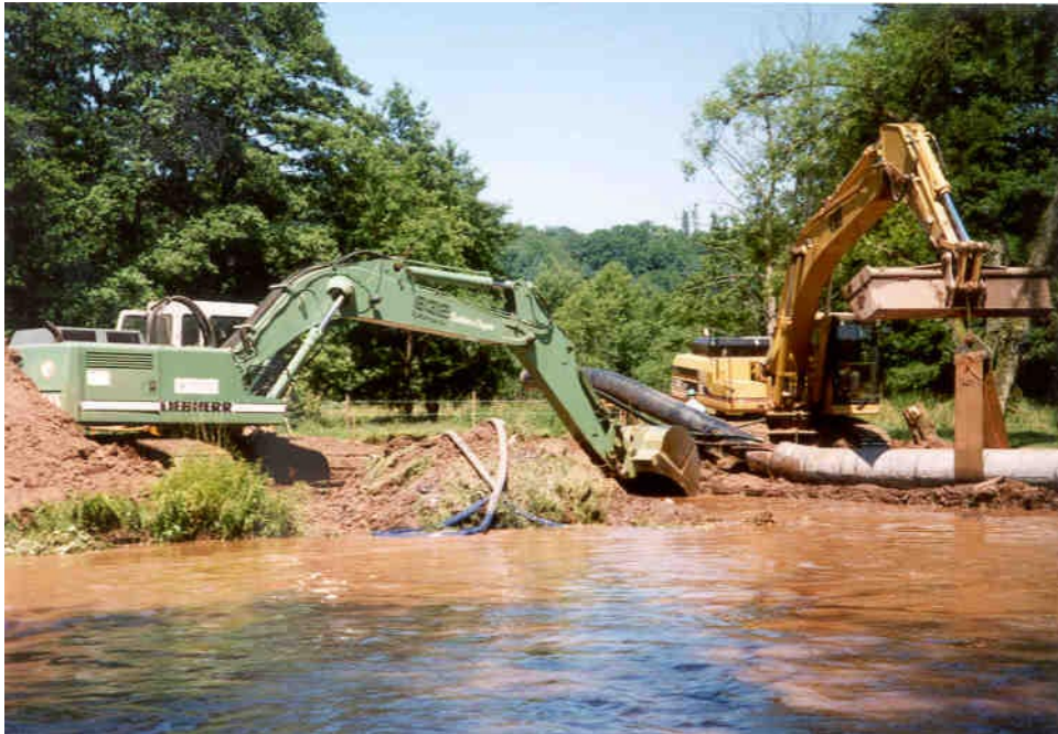
Bild 4. Offene Verlegung in der Prims mittels Formdüker
