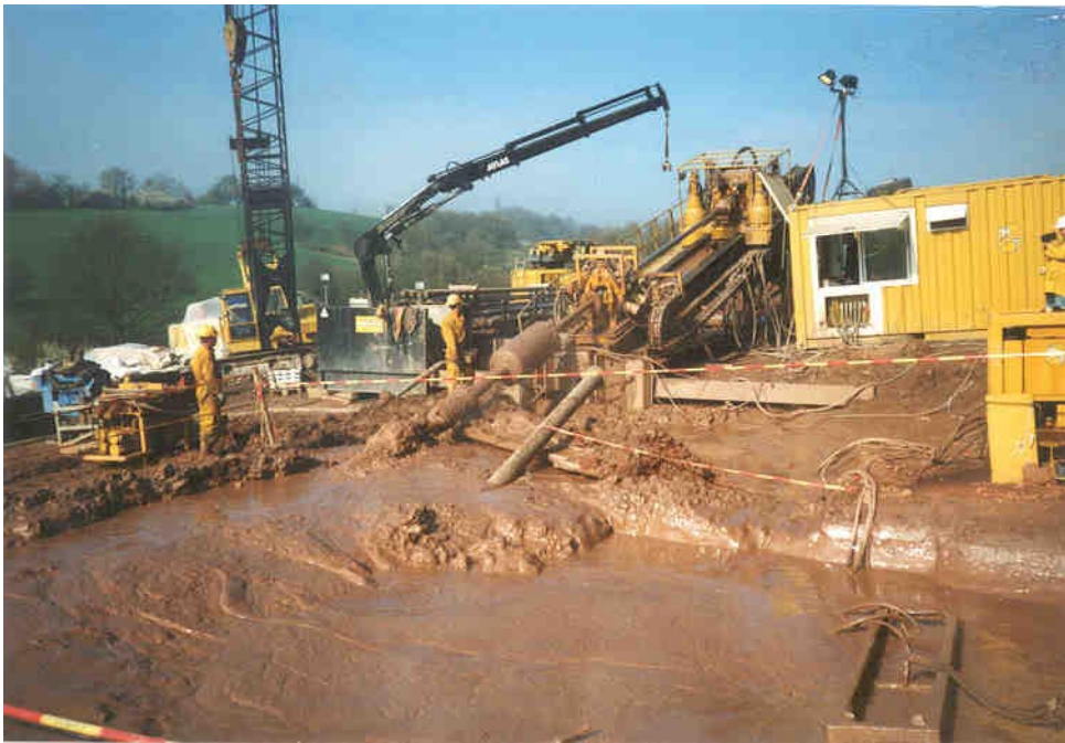
Bild 3. HDD-Anlage bei Niederlinxweiler: Einziehen des Rohrstrangs
