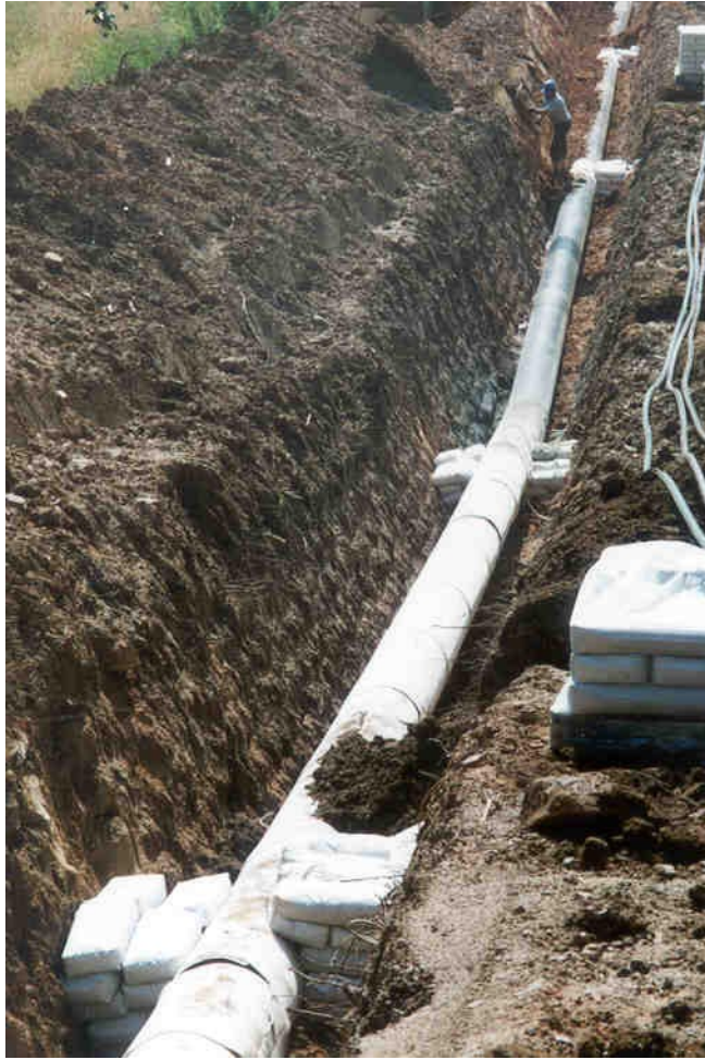
Bild 5. Einbau von Freispülsicherungen
