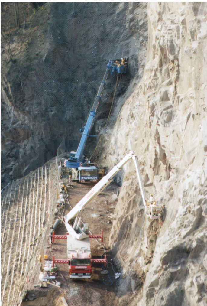
8. Ankereinbau mit Hebezeug
