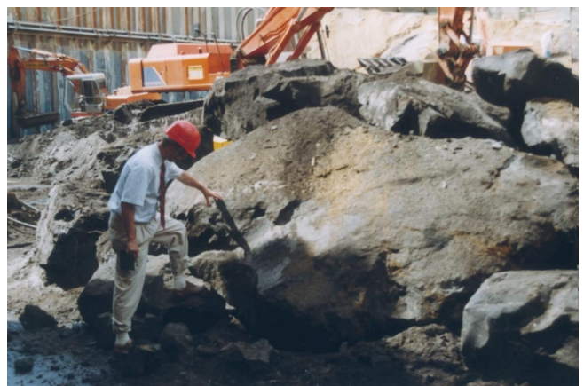
Bild 6: Tertiärquarzitblock in der Baugrube Petersbogen, Länge ca. 4,5 m, Breite ca. 2,5 m, Höhe ca. 1,8 m
