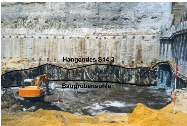
Bild 11 Im Niveau der Baugrubensohle Petersbogen (ca. 98,9 m NN) ausgeräumter Braunkohlenschluff und Braunkohle (S 14.3) des Bitterfelder Flözkomplexes
